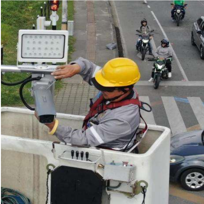
Instalación 14 cámaras de reconocimiento facial, 5 LPR y 2 cámaras 360 (Cambio por obsoles
